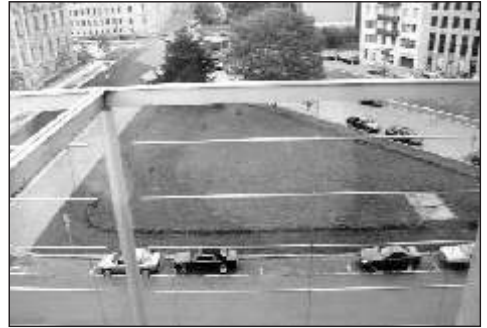
Hier entsteht die Tiefgarage
